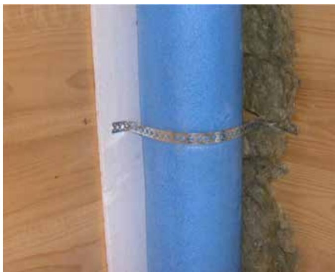
Tubazione di scarico ricoperta con materiale fonoisolante
