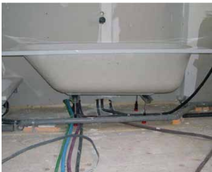
Impianti di adduzione e scarico per vasca
