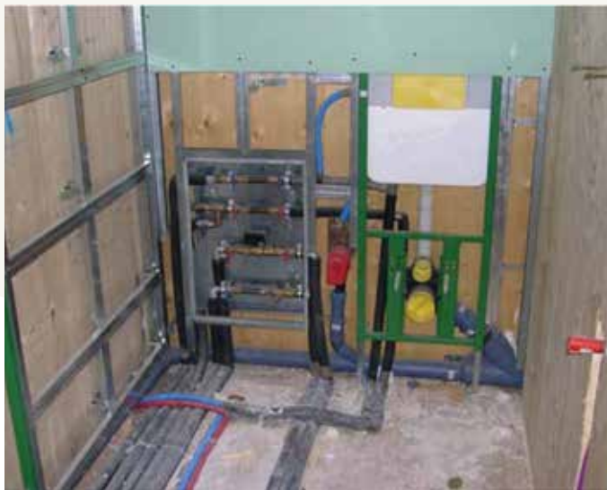
Impianti di adduzione, scarico e riscaldamento: posizionamento in intercapedine contro parete a pannello masiccio multistrato
