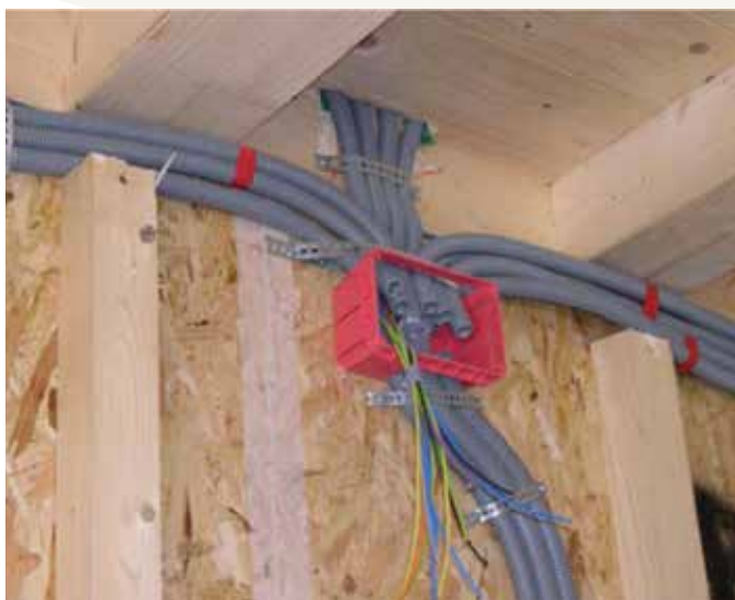
Parete con intercapedine per impianti: scatola di derivazione
